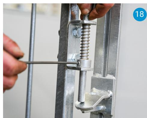
An der oberen Flacheisenlasche die Tür ebenfalls mit einer Schraube M10 X 35, Mutter und Beilagscheibe fixieren (16) - kann zum Schluss dann nachgezogen werden, dass die Tür einfach schließt. Den Verriegelungshalter mit zwei Schrauben M10 X 40 + Mutter montieren (17). Abschließend den Auflaufriegel in den Halter schieben und mit der Feder tief genug einstellen (18).
