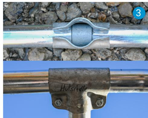
Die 8 Zeltbogenteile mit den Verbindern (1) zu 4 großen Bögen zusammenlegen. Auf den 1. Zeltbogen 5 Hutschellen schieben (2). Die mittlere Hutschelle muss mittig über dem Verbinder liegen (3), die ersten beiden Hutschellen auf der linken und rechten Seite der mittleren Hutschelle mit einem Abstand von 1,00m und die äußeren Hutschellen mit einem Abstand von 1,20m zur vorherigen Schelle aufschieben.
