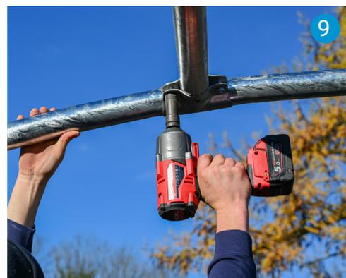
Auch an den 3. Bogen werden die 5 Kreuzschellen angebracht und die 2"-Rohre können zwischen 2. und 3. Bogen mit Schrauben M10 x 35 inkl. Mutter M10 geschraubt werden (7). An den 3. Bogen können die restlichen fünf 2"-Rohre fixiert werden. Auf den 4. Bogen werden 5 Hutschellen geschoben, mit Schrauben M10 x 35 inkl. Mutter M10 fixiert, sodass der 4. Bogen auf die 2"-Rohre geschoben werden kann (8) und abschließend festgeschraubt wird (9).
