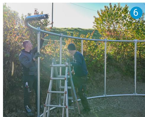
In die Hutschellen 2"-Rohre stecken, ausrichten und mit Schrauben M10 x 35 inkl. Mutter M10 fixieren (4). Die 5 Kreuzschellen an den 2. Zeltbogen anbringen und mit Schrauben M10 x 35 inkl. Mutter M10 fixieren (5). Nun wird der 2. Zeltbogen auf den 1. Zeltbogen gehoben und die fünf 2"-Rohre zwischen Hut- und Kreuzschelle mit den bereits fixierten Schrauben M10 x 35 inkl. Mutter festgeschraubt (6). Anschließend können die beiden verschraubten Bögen aufgestellt werden.
