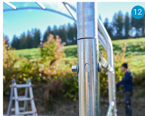
Die montierten Zeltbögen werden nun mit einem Hoflader, Bagger, etc. auf einer Seite angehoben, sodass diese in das erste Panel gesteckt werden können (10/11). An den vorderen 3 Steckpunkten, werden die Zeltbögen mit dem Panel mit Schlossschrauben M12 x 70 inkl. Beilagscheibe (gebogen) und Hutmutter M12 verschraubt. Der Flachkopf der Schrauben muss dabei nach außen zeigen (12). Das zweite Panel wird wie bei Punkt 10 - 12 auf der gegenüberliegenden Seite montiert.
