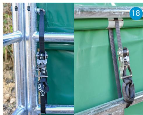
Nun wird die Rückwand-Plane mit dem 25mm Gurt am Grundgerüst verschlauft (16), in der Mitte beginnend und an den Seiten mit VA-Ratschen links und rechts am Panel verspannt (18). Alu-Rohre mit Verbindern zusammenführen, in Hohlraum einführen und mit 3 VA-Ratschen und Gurt am hinteren Panel verspannen (17/18).
