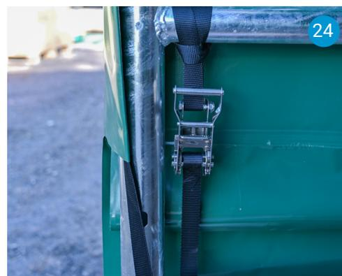
Seitliche Alu-Rohre mit VA-Ratschen und Gurt an 6 Punkten am Panels links und rechts verspannen, wie bereits die Rückwand verspannt wurde (22). Zum Schluss die Spanngurte der Giebelüberhänge straff ziehen und mit der untersten waagrechten des Panels (Fuß) verbinden (23/24).
