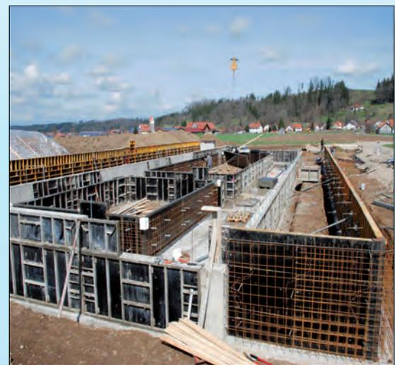
*Schalungsarbeit bei Güllekanal mit Aufkantung*
