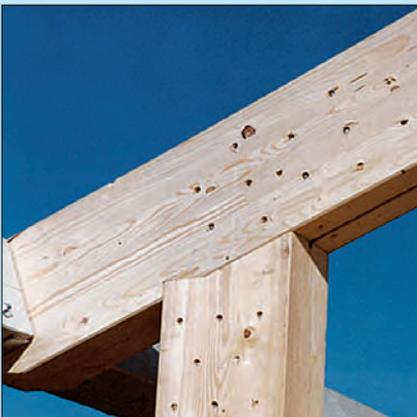
*Biegesteife Eckverbindung durch eingearbeitete Schlitzplatte*
