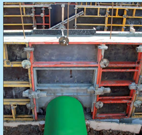
*Detailansicht von Schalung bei Querkanal mit Rohr KG 2000*
