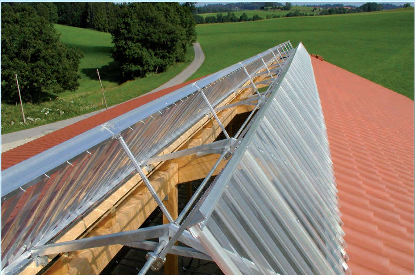
*Der Entlüftungsfirst mit dem optimalen Luftaustritt für die moderne Laufstallhaltung*
