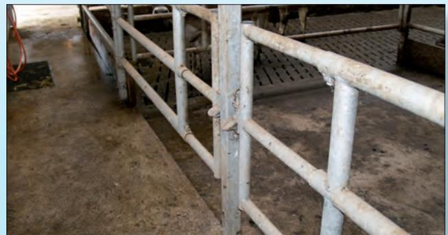
*Rohrtüre 3-lagig mit Vierkantrrohr, Rohr zum
