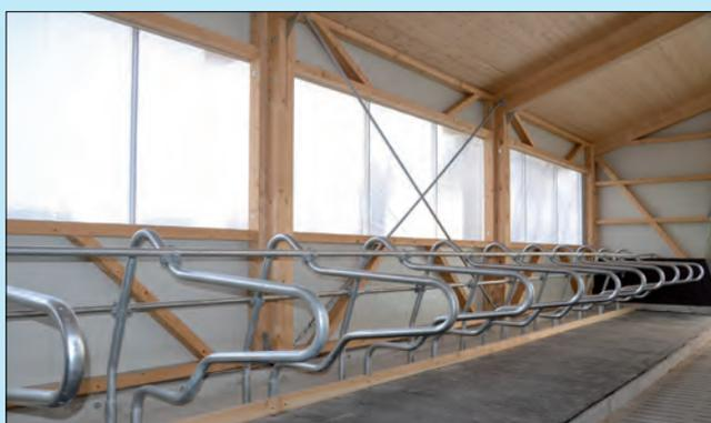
*Combi Basis 2" mit Nackenrohr und Begrenzungsrohr*
