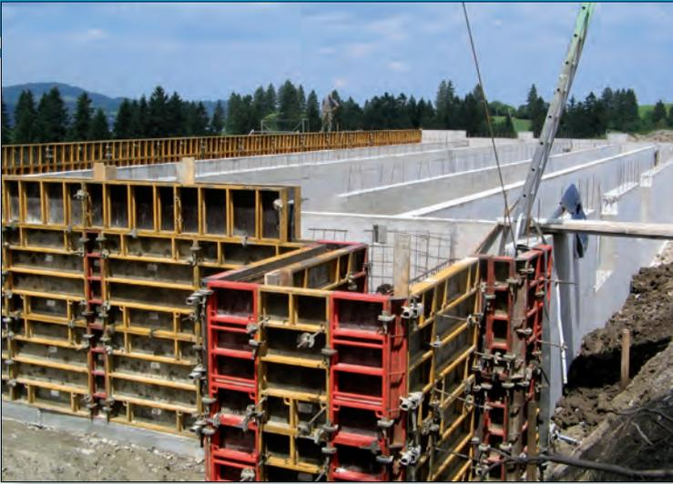
*Schalungsarbeiten bei Güllekeller mit Slalomsystem*
