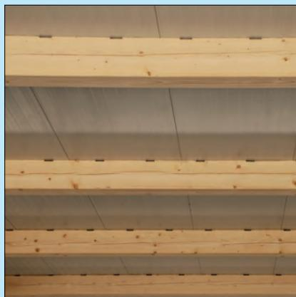
*Einhängepfetten werden in der Regel mit Lüftungsschlitzen gefertigt. Dadurch wird eine längere Sauberkeit der Decke gewährleistet.*
