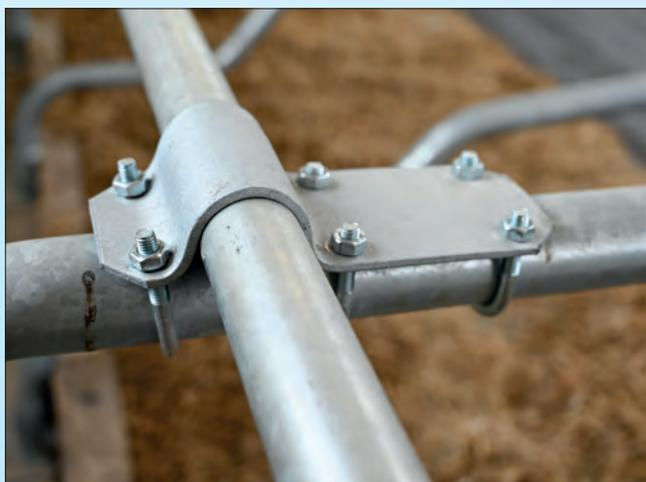
Flacheisenschelle für Stabilisierungsrohr
