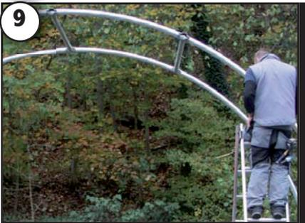
9 T-Flansch an 2. Zeltbogen anbringen, 2"-Rohr (1.90 m) zwischen Hut- und T-Flansch stecken, total 5 Rohre, ausrichten, mit Schrauben M10x35 inkl. Mutter festschrauben.
