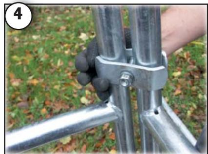
Die Elemente mit je 2 Eckverbindern (aus Flacheisen) mit Schlossschrauben 12x65 inkl. Muttern zusammen verschrauben. Der Flachkopf der Schrauben muss dabei nach aussen zeigen.
