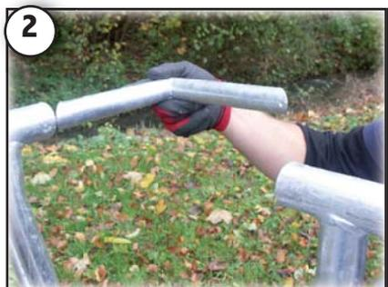
Die 3 Zaunelemente in U-Form aufstellen und mit den 2 runden Eckverbindern oben zusammenführen.
