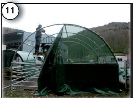
11 Rückwand-Plane mit 25 mm Gurt an Grundgerüst verschlaufen...
