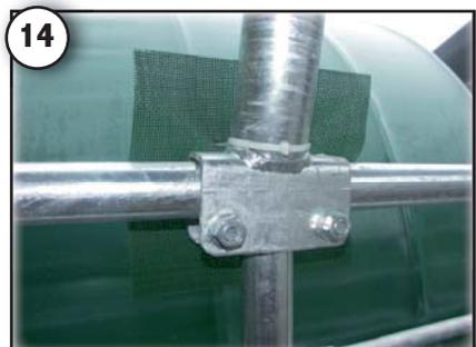
14 Bei allen Rohrbogenanschlüssen (8 Stück) sowie Zaunelement-Kopplungen (3 Stück) PES-Schutzplane 20 x 20 cm zwischen Gerüst und Dach-Plane verkleben.
