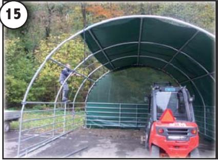
**15** Nach dem Ausbreiten der Dach-Plane auf beiden Seiten die Alu-Rohre einschieben und die Plane mit Hilfe von einem Seil über das Gerüst ziehen.
