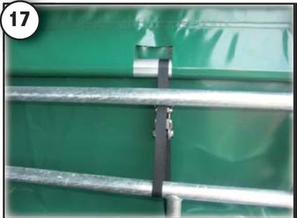
**17** Seitliche Alu-Rohre mit VA-Ratschen mit Gurt an 6 Punkten an Zaunelement verspannen.
