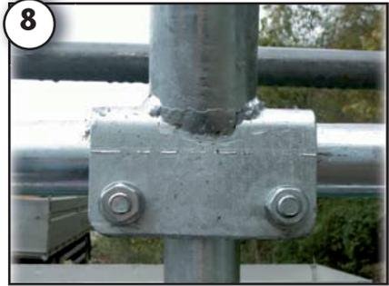
8 Zeltbögen ausrichten (1.90 m Distanz) und mit Schlossschrauben M12x65 inkl. Mutter feststellen. Der Flachkopf der Schrauben muss dabei nach aussen zeigen.
