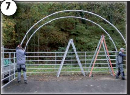
7 Hinterster Zeltbogen (mit Hutschellen) und 2. Zeltbogen (leer) auf Zaunelemente stellen. Hutschellen mit Meter ausrichten und mit Schrauben M10x35 inkl. Mutter fixieren.
