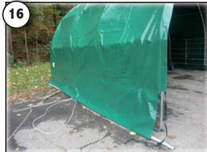
**16** Die Plane gleichmässig über das Gerüst legen, die Überhänge auf den Giebelseiten sowie die Enden bei den Alu-Rohren sollten überall gleich sein.
