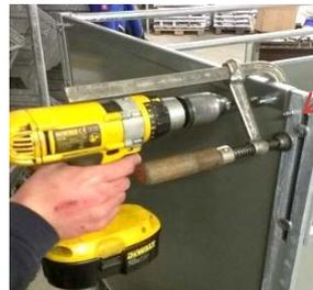
Mit einem 7mm Bohrer durch die vorgegebenen Löcher bohren und von Innen nach Außen verschrauben
